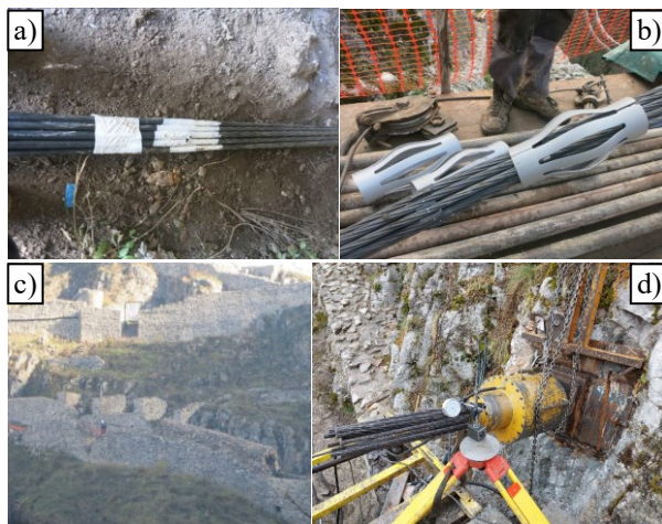
Slika 7. Izgled sidara na gradilištu a) prelaz sa slobodne na sidrišnu deonicu, b) izgled distancera i unutrašnjeg raspoređivača, c) donošenje sidra na gradilište, d) trenutak ispitivanja sidra br. 2
