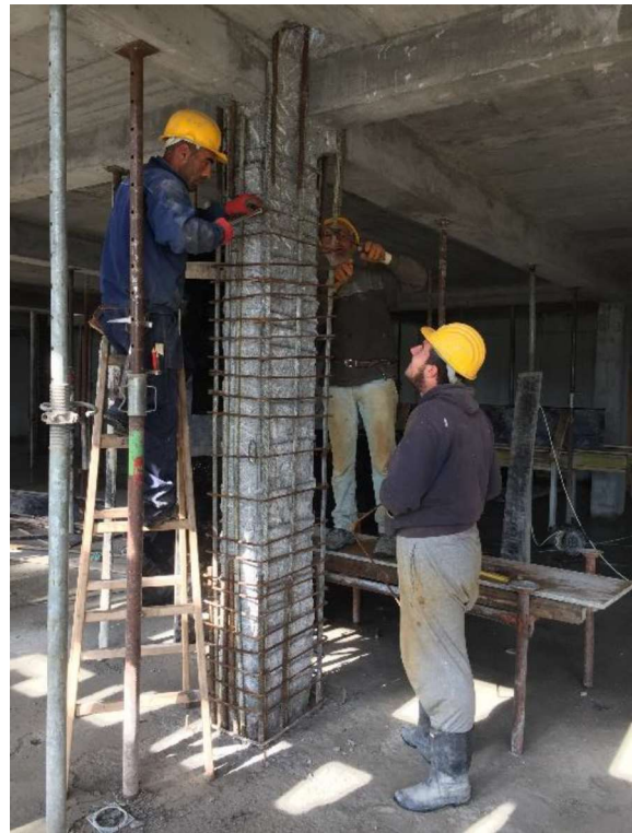
Slika 6. Ojačavanje pravougaanih stubova dodatnom armaturom
