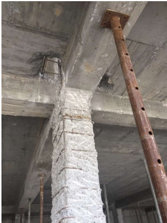
Slika 6. Ojačavanje pravougaanih stubova dodatnom armaturom
