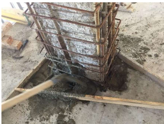
Slika 7. Betoniranje novog betonskog plašta oko stubova
