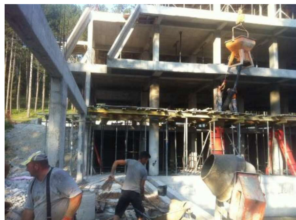
Slika 7. Betoniranje novog betonskog plašta oko stubova
