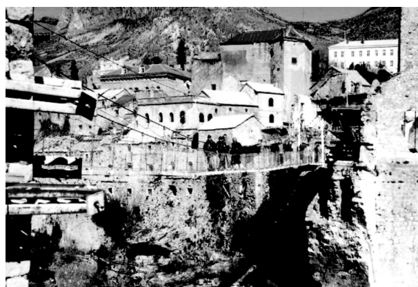
Slika 14. Privremena konstrukcija za prelazak preko Neretve
