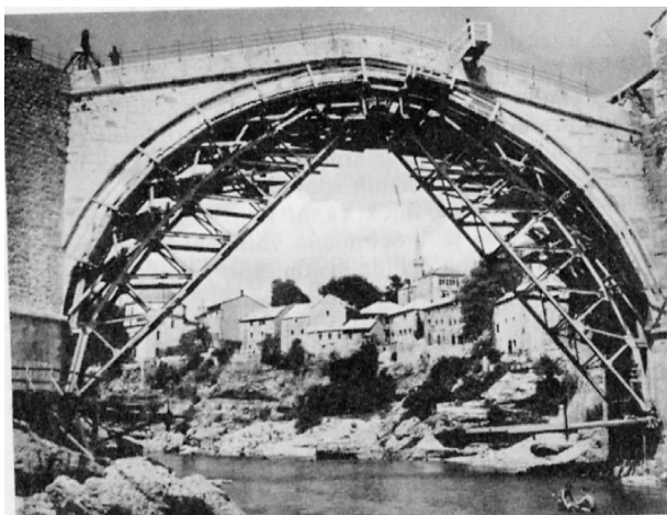
Slika 9. Svodna skela za potrebe injektiranja svoda
