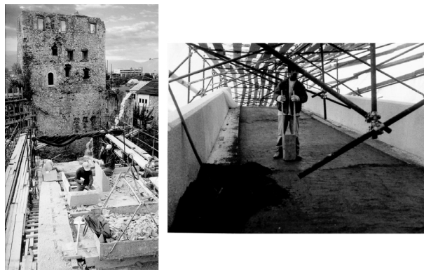
Slika 16. Oblaganje luka kamenom i izrada hidroizolacije
