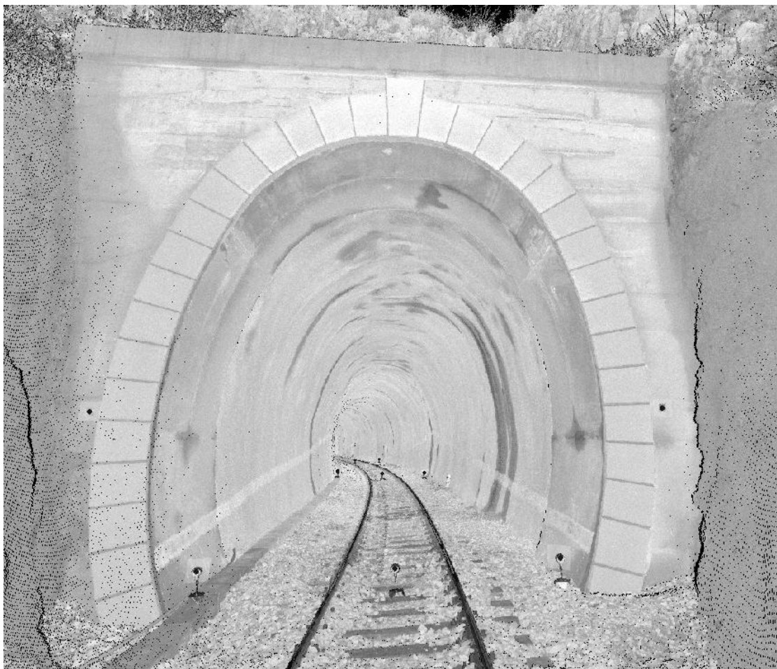
Slika 1 - Oblak tačaka tunela sa detektovanim Riegl retro-reflektivnim signalima. Vezne tačke na podu tunela i kontrolne tačke na zidu tunela
