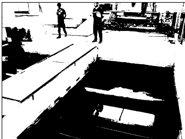
Slika 1: Levo - dovodni kanal (pokriven limenim pločama) i filtarsko polje (levo i desno od kanala) u S.F.S. koje nije u funkciji ; Desno - dovodni kanal (pokriven pločom) i filtarsko polje (levo i desno od kanala) u N.F.S. koje takođe nije u funkciji.
