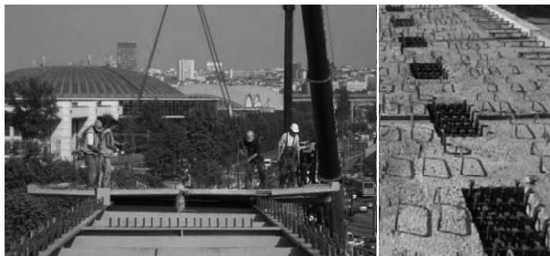
Slika 1.- Prefabrikovane betonske ploče sa rupama za grupisane zavarene moždanike
