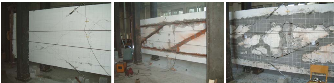
Slika 8. Model dvospratnog zida pre sanacije, posle sanacije i u fazi ispitivanja Figure 8. Two-storey wall model, before retrofit, after retrofit and during testing.
