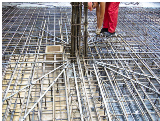
Slika 1 Izgled elementa sa moždanicama i njihova ugradnja [10] [11]
