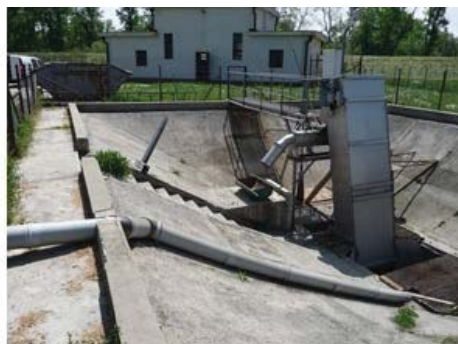
Slika 2. KCS Kolubara: spoljni izgled (levo), rešetka na dovodnom kolektoru (desno)
