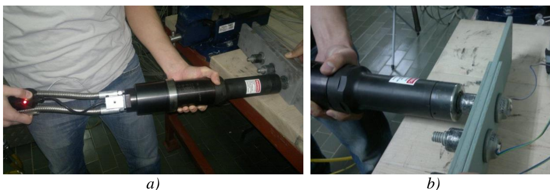
Slika 2.7: Ugradnja HBT zavrtnjeva prečnika 20 mm a) crvena lampica kao indikator rada opreme za ugradnju b) postavljanje opreme u položaj za rad
