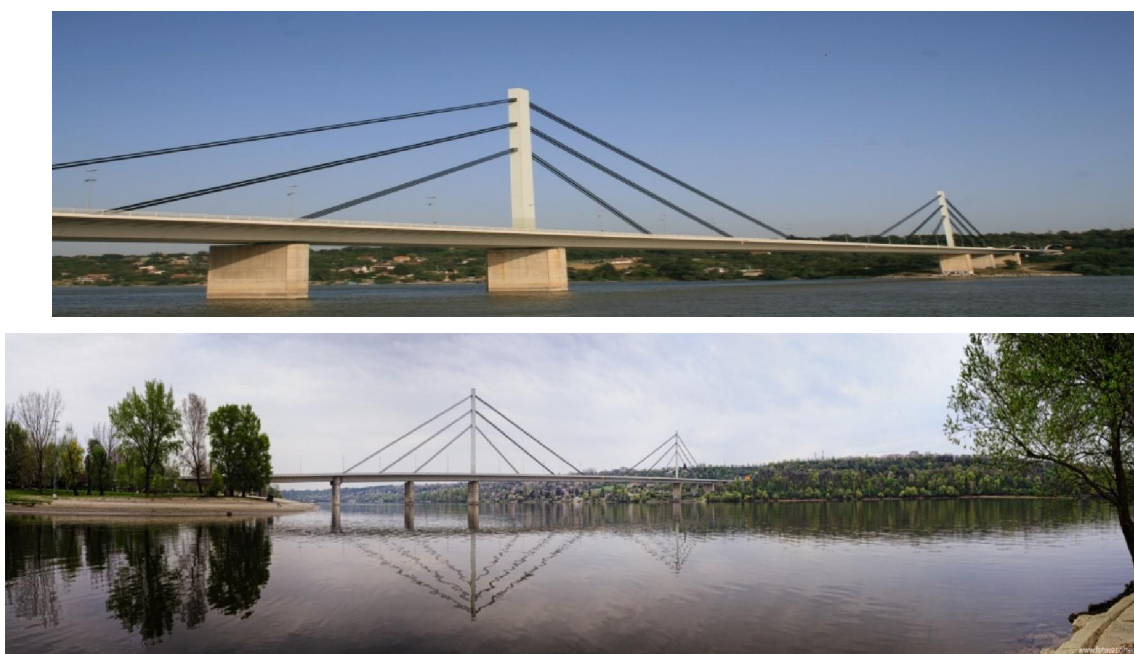
Слика 6.35: Панорамски снимци моста Слободе
