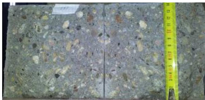
Slika 7.6 Poprečni presek uzorka sa tragom prodora vode (SCC sa spršenim recikliranim betonom)
