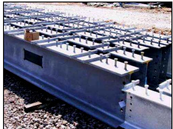
Слика 1.19 Изглед I носача са уграђеним можданицима за спрезање
