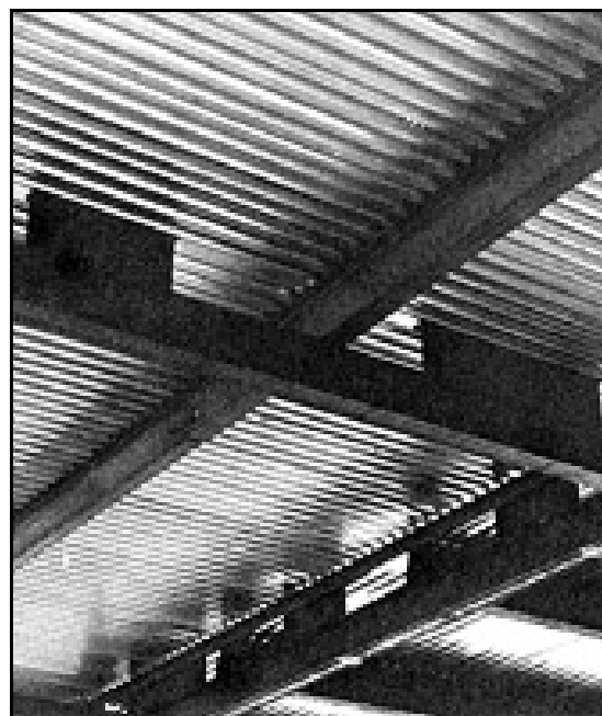
Слика 1.30 Изглед СТУБ носача са плочом на профилисаном лиму
