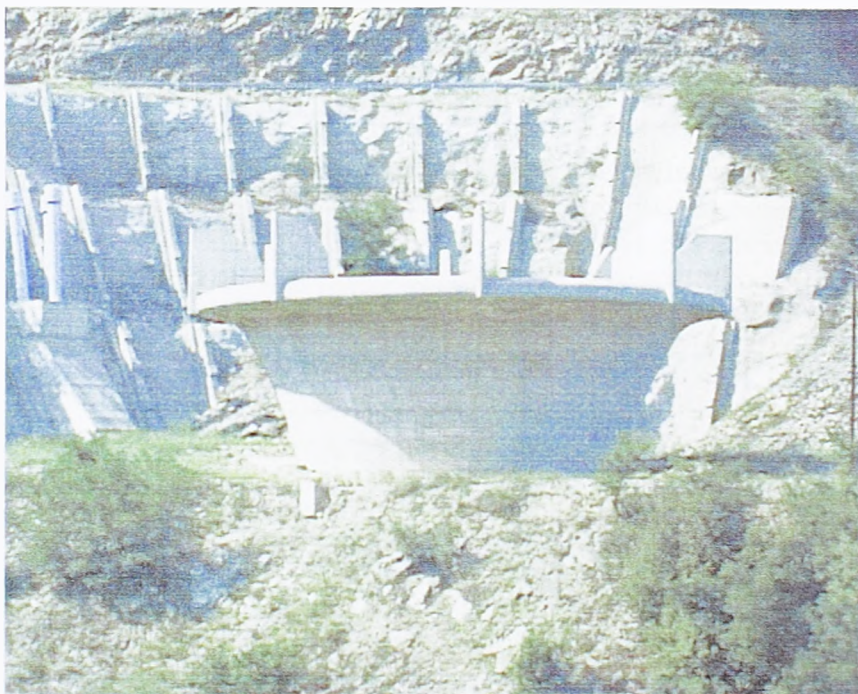
Слика 1.3: Брана Првонек – осигурање преливног шахта
