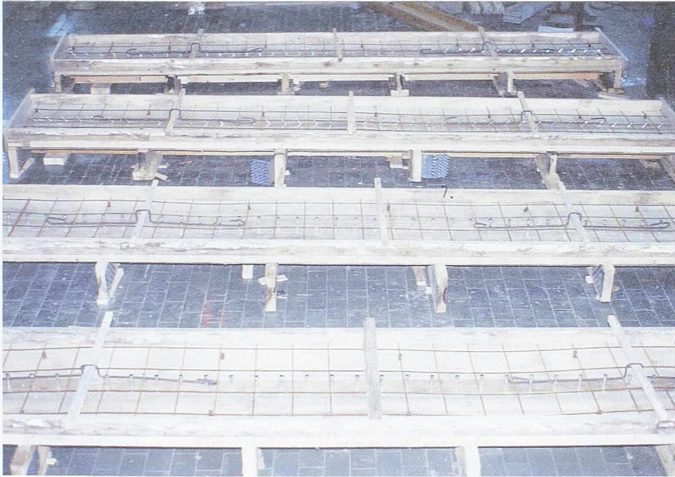
Slika 3.19 - Nosači tipa ZP i ZK neposredno pre betoniranja
