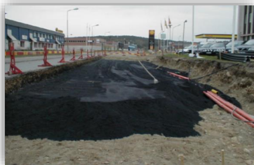
Slika 2. Rekonstrukcija ulice korišćenjem granulirane zgure - Boliden Iron Sand u Švedskoj [3]
