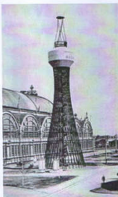
слика 5. (Водени торњ у Доњем Новгороду. Прва грађевина на свету, која је имала облик обртног хиперболиода. Саграђен је 1896. године, а пројектант је руски архитекта Владимир Шуков.)
