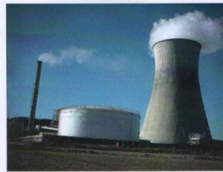
слика 9. (Силос термоелектране хиперболичне структуре.)
