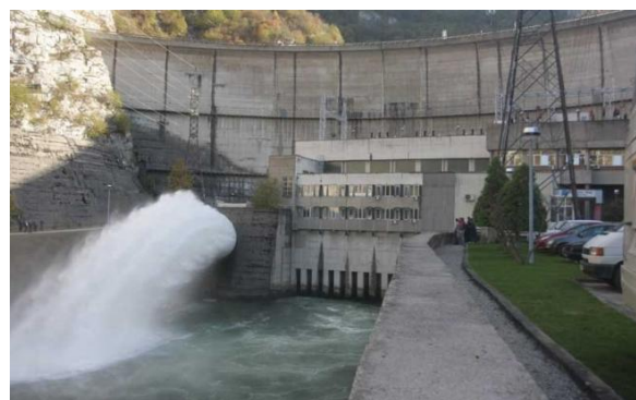
Slika 3. Temeljni ispust na brani Bočac
