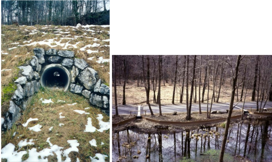
Slika 10. Inženjerski objekti koji omogućavaju bezbedno kretanje životinjskih vrsta Izvor: (L1)
