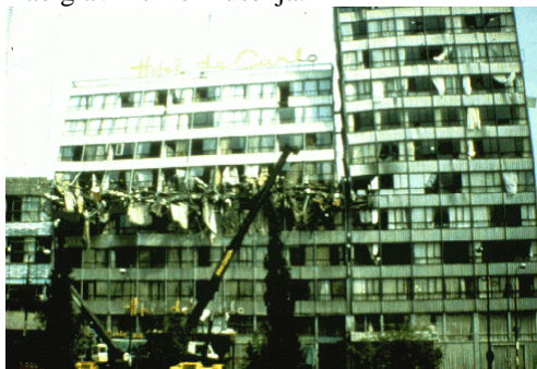
Slika 2. Rušenje celog sprata hotela usled uzastopnih udara zgrade levo tokom zemljotresa u Meksiko Siti. Slika preuzeta od C. Arnold, Building Systems Development, Inc.
