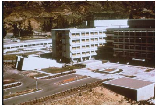
Slika 1. Srušen toranj bolnice „Olive View Hospital,, Slika preuzeta od NOAA/NGDC, E.V. Leyendecker, U.S. Geological Survey
