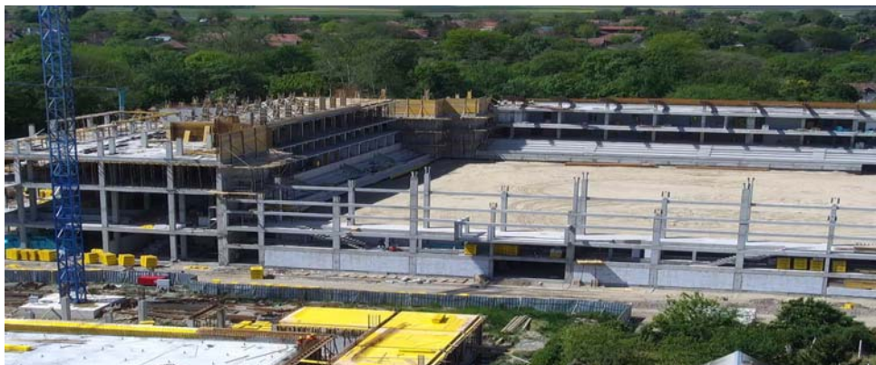
Slika 1. Konstrukcija stadiona u fazi izgradnje
