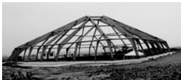
Slika 5. Nadstrešnica iznad Viminacijuma u Kostolcu. Prostorni sistem. Raspon po dijagonali: 40 m.
