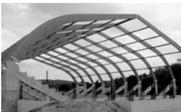
Slika 3. Sportska dvorana u Grockoj. Statički sistem: luk na tri zgloba raspona 36,9 m
