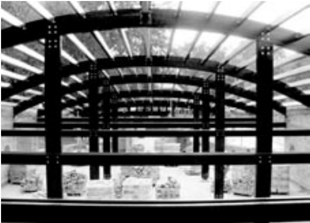
Slika 7. Krovna konstrukcija restorana u Novom Sadu u obliku okrenutog čamca. Raspon: 15m
