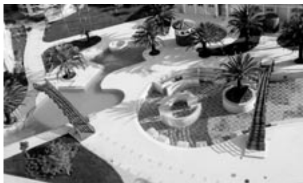
Slika 4. Pešački mostovi preko bazena hotela Splendid u Bečićima. Mostovi su izrađeni od tikovine, a metalni vezni elementi su od nerđajućeg čelika. Raspon: 16,5m
