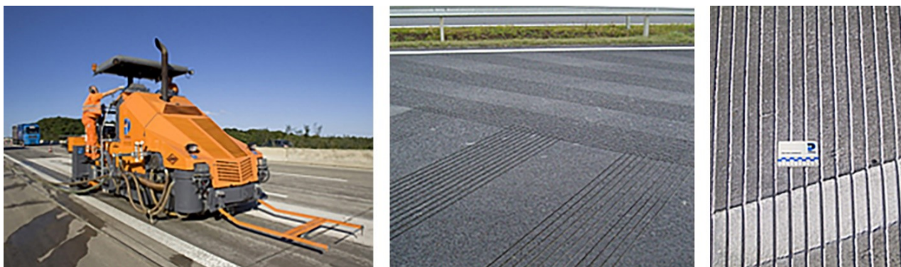
Slika 13. Žlebljenje asfaltne kolovozne površine usecanjem uskih brazdi specijalnim mašinama (Izvor: [12])
