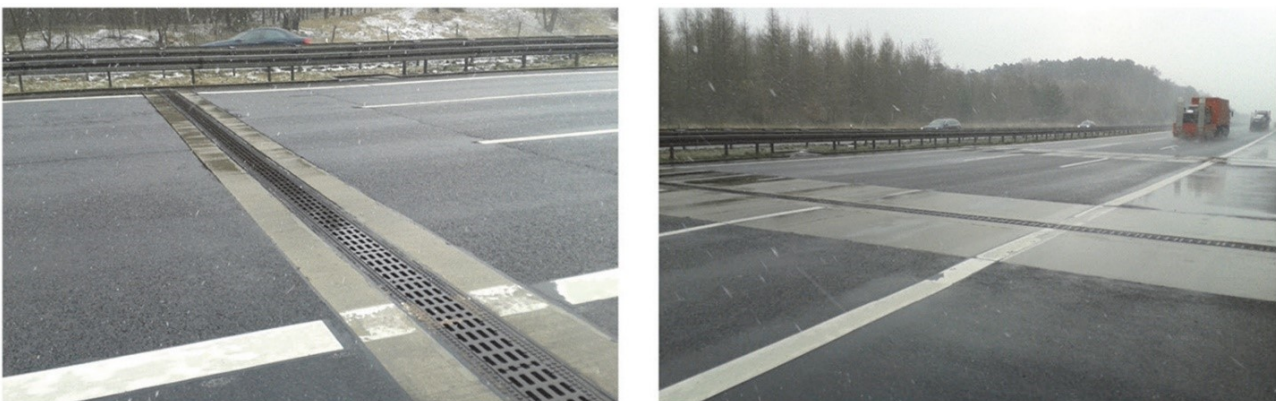
Slika 12. Poprečne slivničke rešetke ugrađene u zoni infleksije na autoputu A10 u Nemačkoj (Izvor: [9])
