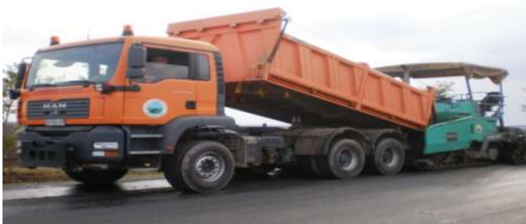
Слика 110 - Уграђивање битуменом везаних материјала на државном путу првог реда
