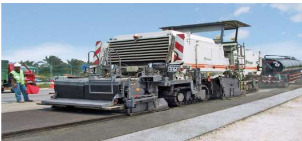
Слика 111 - Производња и уграђивање рециклираног слоја CR технологијом
