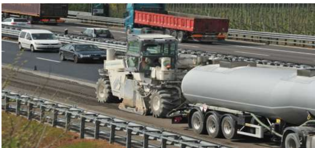
Слика 112 - Производња и уграђивање рециклираног слоја WR технологијом
