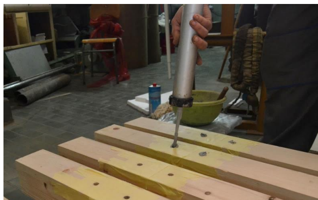
Слика 5.32 Испуњавање рупа епоксидним лепком
