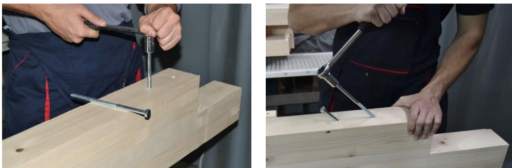
Слика 5.28 Постављање завртњева
