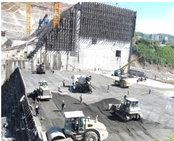
Слика 6. Изградња бране од ваљаног бетона
