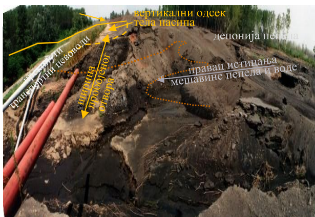
Слика 5. Пробој ободног насипа на депонији пепела ТЕ Костолац 13. јуна 2002. године изазван слегањем и преливањем
