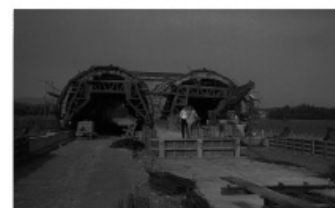
Slika 8.- Primer tunela građenog u otvorenom
