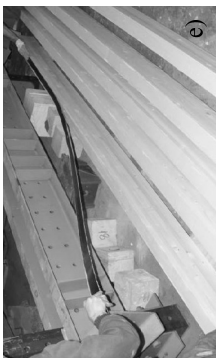
Slika 5. Priprema i lepljenje karbonskih traka
