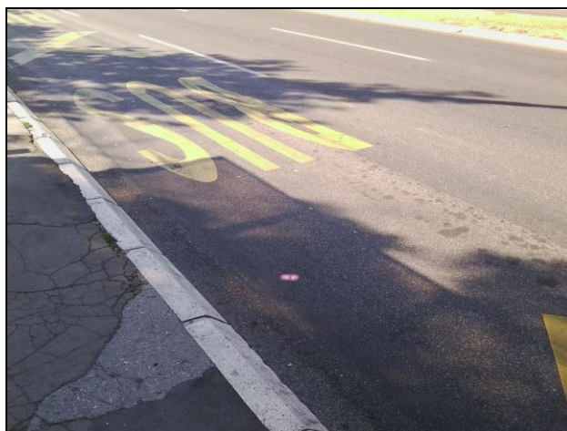
Слика 12. Колотрази на аутобуском стајалишту на левом коловозу
