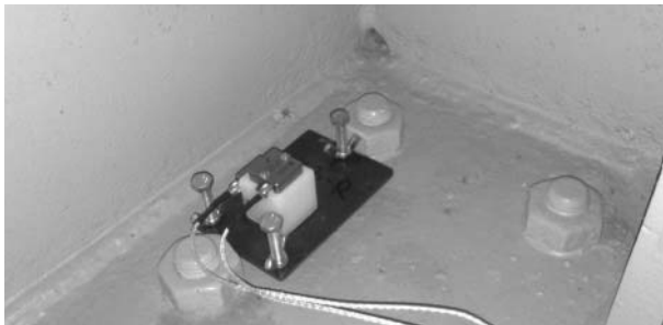
Slika 4. - Položaj akcelerometara tokom merenja ambijentalnih vibracija testirane mostovske konstrukcije
