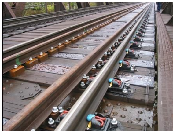
Slika 13. Ugrađeni sistem pričvršćenja sa stezaljkom ZLR (sistem Pandrol VIPA) na mostu Figure 13. Installed fastening system with ZLR clips (Pandrol VIPA system) on a bridge
